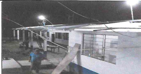
Foto 2: Se observa el cambio de la estructura metalica en el modulo 1
