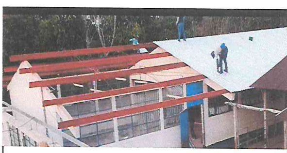
Foto 6: Se observa la instacion de laminas modulo 3.
