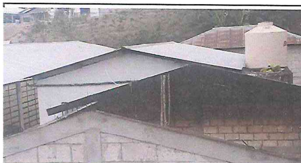
Foto 3: Se observa el retiro de las láminas del modulo 2
