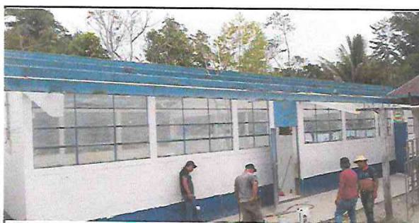
Foto 5: Se observa el cambio de pintura de la estructura metalica. Módulo 3
